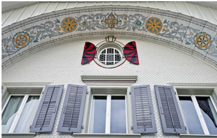
Bauernhaus im Dorf, gegen Südwest bildet das eigenwillige Haus den fulminanten Auftakt zur Sandstrasse, die das Ortsbild bestimmt.
